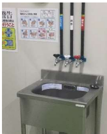
加工室やトイレの入口には電解水の取水口を設置。
